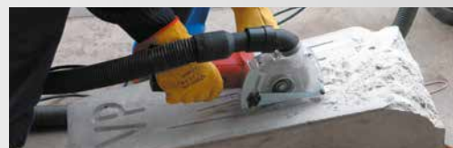
MINI AMOLADORA CORTANDO CON CÁRTER DE ASPIRACIÓN
