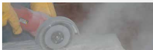
MINI AMOLADORA CORTANDO SIN CÁRTER DE ASPIRACIÓN
